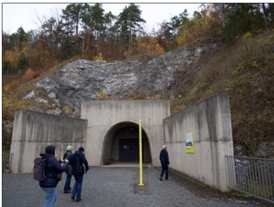
Neuer Eingang zu einem Teil des Stollensystems
