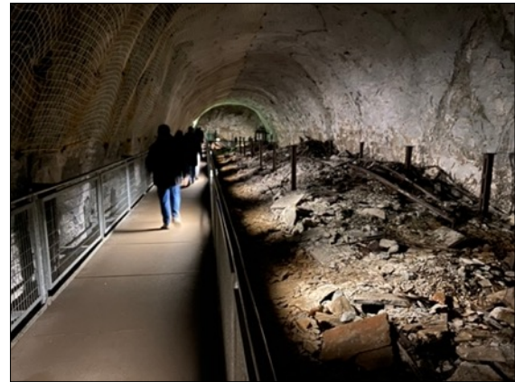
Beim Gang durch einen Stollen mit Explosionsschutt
